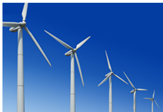
写真3 洋上風力発電装置
