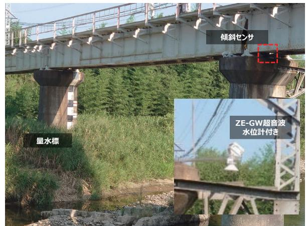
図6 鉄道橋脚の傾斜・水位モニタリング
