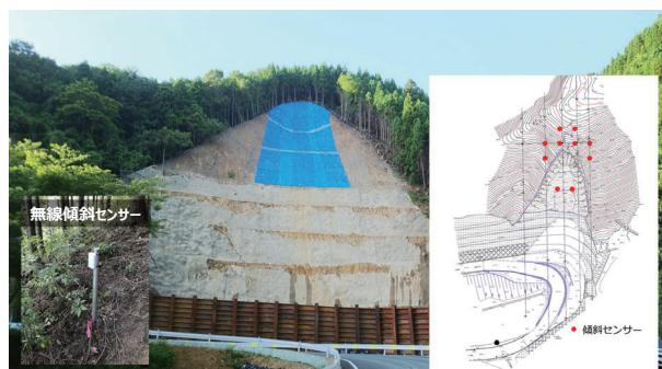
図 8 法面傾斜モニタリング
