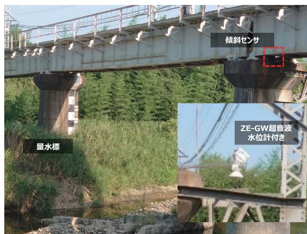
図6 鉄道橋脚の傾斜・水位モニタリング
