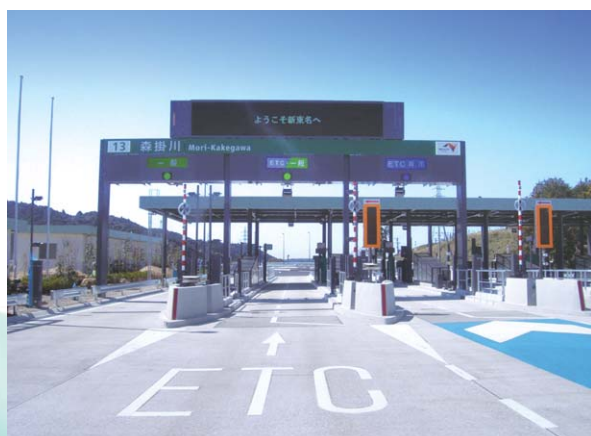
新東名高速道路向けETCシステム
