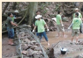
水堰止め堀設置作業
