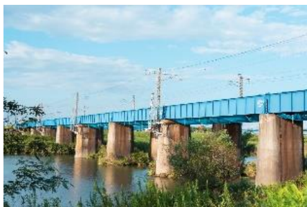
橋梁（掘削監視）
