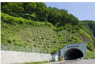
斜面・のり面監視
