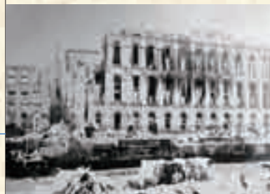
関東大震災で被災した京橋電話局
