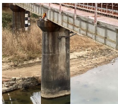
設置した橋脚
