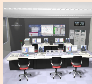
消防システム
