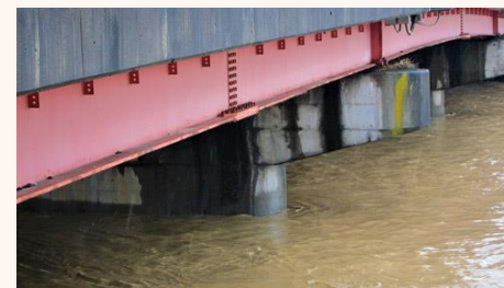
増水による通行止め
