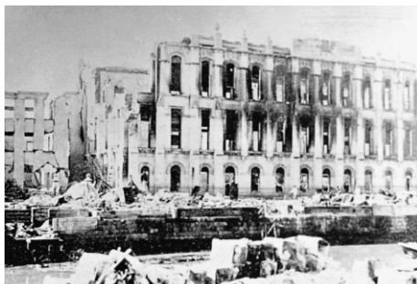
被災した京橋電話局
