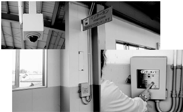
写真1 現場での利用シーン：駅構内のカメラとIPインターホン
