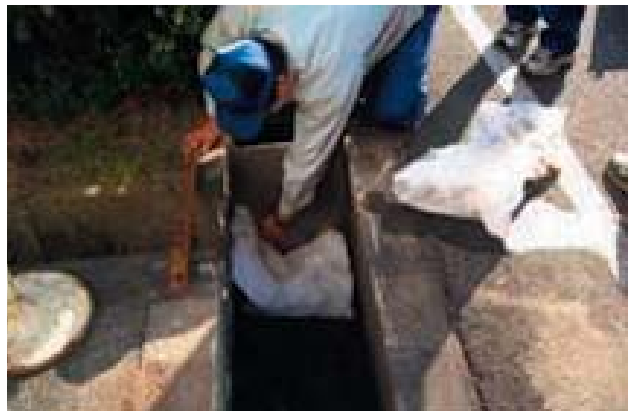
OKI 富岡地区 重油流出防止訓練
