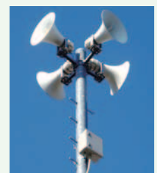
既存の屋外拡声機に設置した全天候型920MHz帯無線BOX
