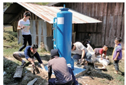
飲用水ろ過装置の設置
