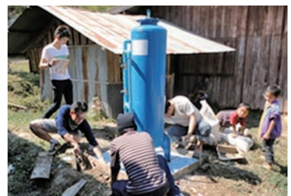
飲用水ろ過装置の設置
