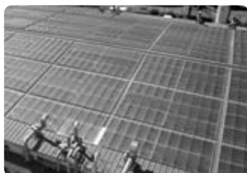
遮光断熱素材を敷設した工場
