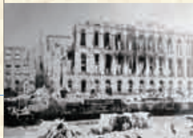
関東大震災で被災した京橋電話局
