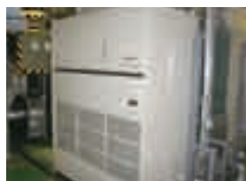
芝浦サイトに導入したパッケージ空調機
