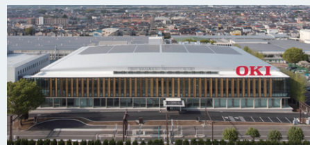
OKI本庄工場H1棟
