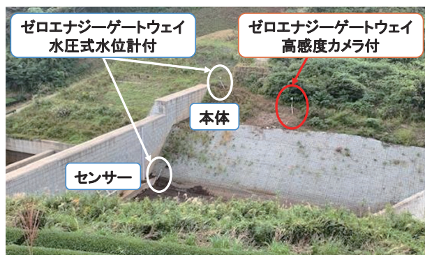
図1 雨水貯留池監視 機器設置例
