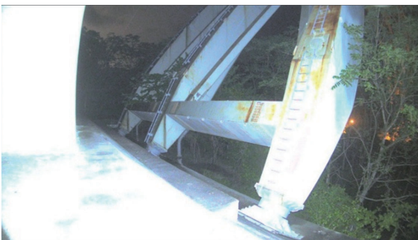
写真6 支承監視 照明を用いた夜間撮影画像
