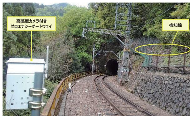
図5 落石遠隔モニタリング
