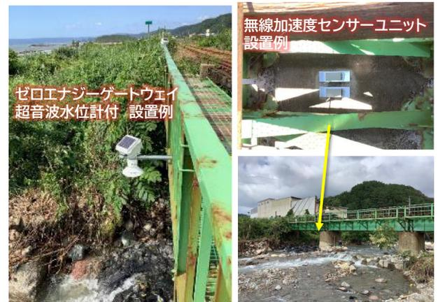
図3 鉄道橋梁への設置例
