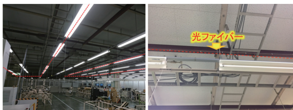
(a) 工場内天井への光ファイバー敷設
