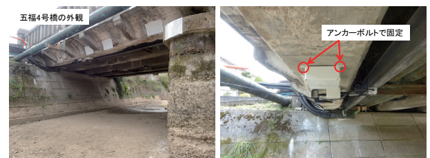
図6 五福4号橋の外観とセンサー設置の様子
