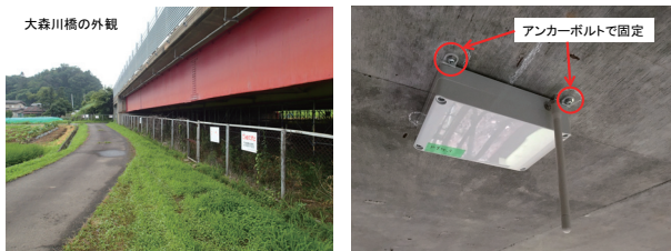
図4 大森川橋の外観とセンサー設置の様子
