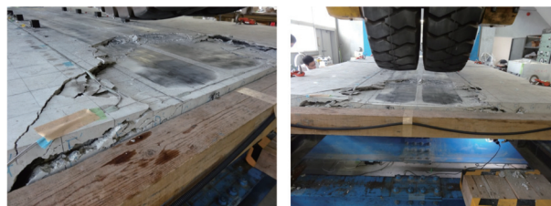
写真2 試験終了後の床版の様子
