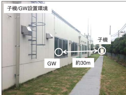
写真1 システムの設置状況
