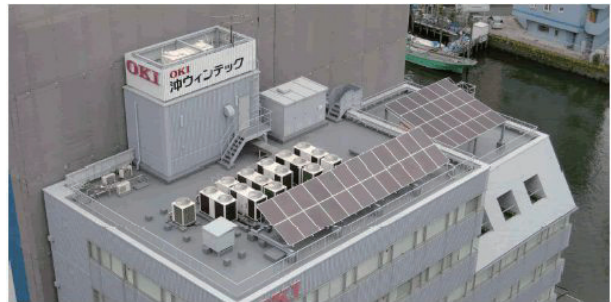
— 本社屋上に設置した太陽光発電設備 —
