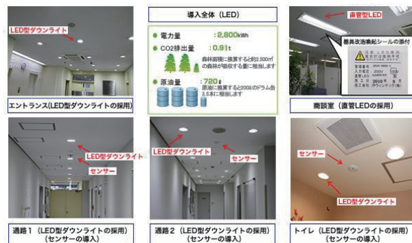
図5 沖ウインテック本社のLED照明の設置状況
