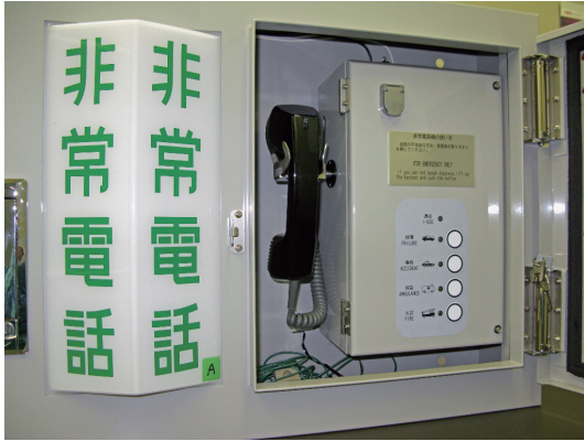
写真2 壁面収容箱に収容した非常電話機
