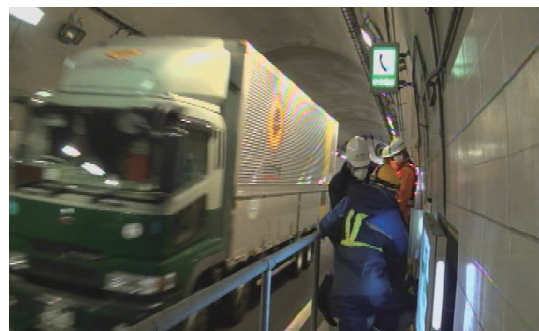
写真1 トンネル内の路側帯
