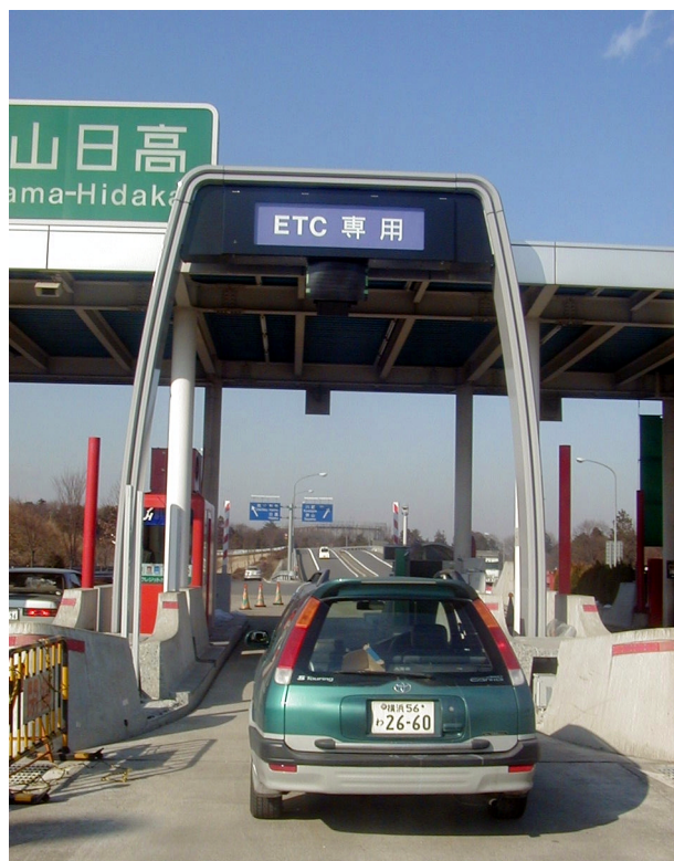
図5 ETC料金所検証作業
