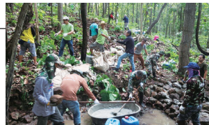
水堰止め堀設置の様子
