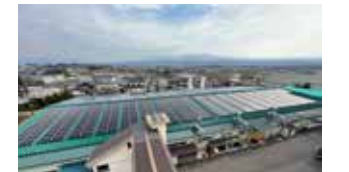
OKIネクステック太陽光パネル
