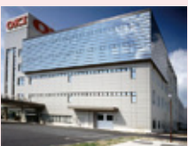
長野 OKI 社屋外観
