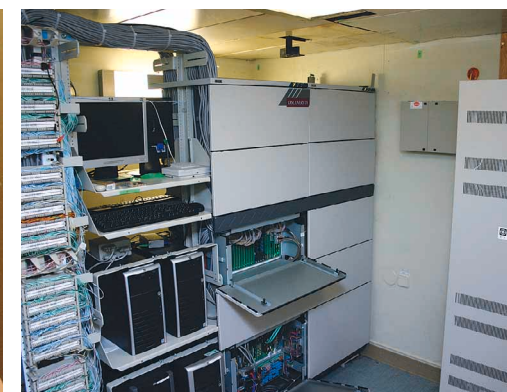
二重化されたDISCOVERY01(中央)と無停電電源装置(右)活用している
