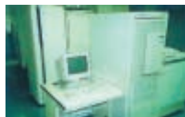
事務所センターのサーバ
