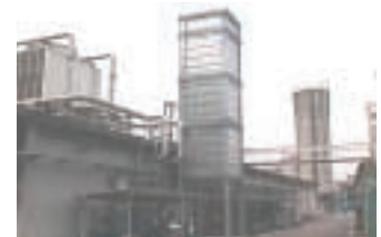
●防音工事了た煙突(2001年度事例)
