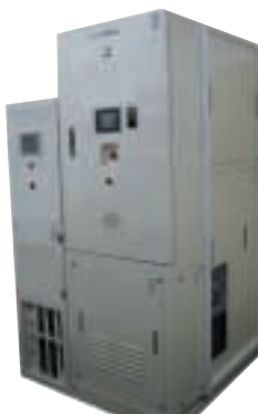
●有害ガス湿式処理装置
