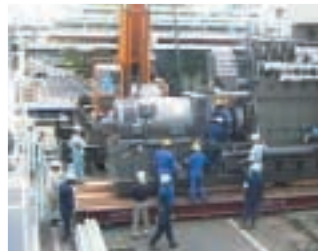
●コージェネレーションシステムの設置(2000年度事例)
