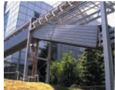
●配管は地上に設置(2001年度事例)
