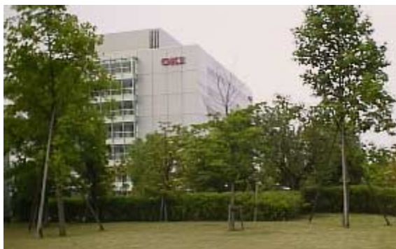
八王子地区構内
