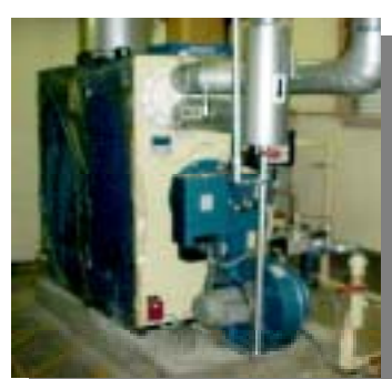
天然ガスボイラー 新設
