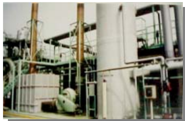
廃油処理委託業者の調査
