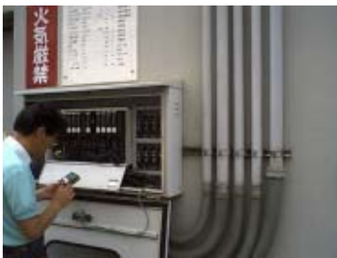
ガス漏洩時対応訓練
