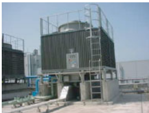
フリークーリング導入のため、増設したクーリングタワー
