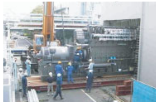
コージェネレーションシステム据付
