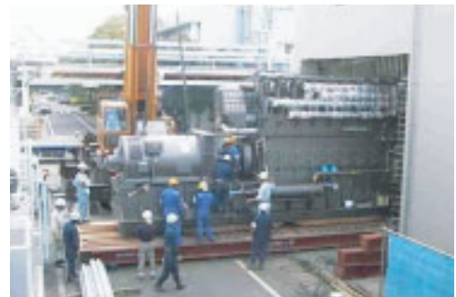
コージェネレーションシステム据付
