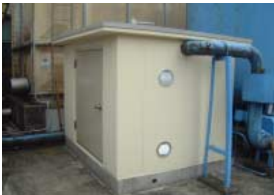
井水濾過ポンプへの防音対策
