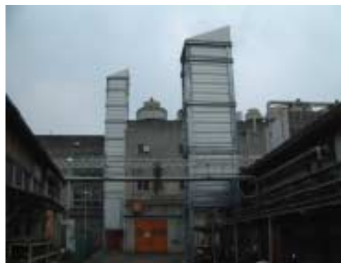
冷温水発生機の煙突への防音壁設置
