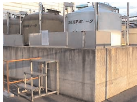
廃水処理槽を囲うコンクリート枠
