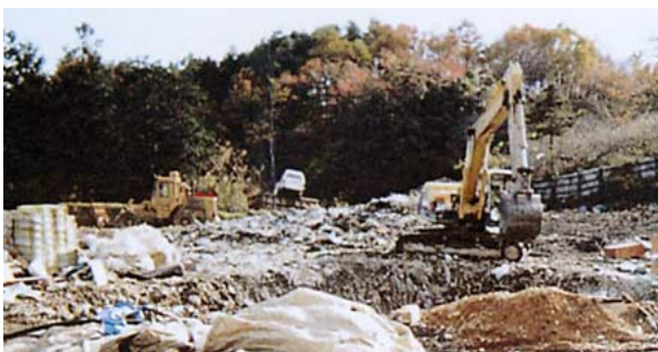
見学を行った最終処分場
