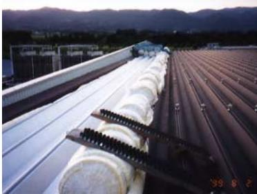
◀ 工場の屋根を二重化し断熱効果を向上することにより、冷暖房エネルギーを削減（沖データ 福島）
