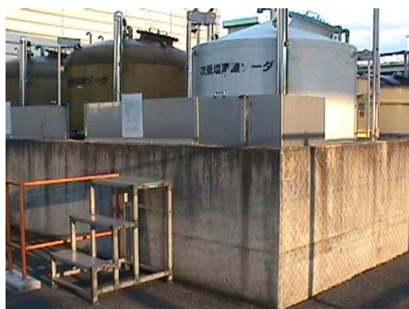
廃水処理槽を囲うコンクリート枠(富岡地区)
