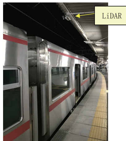
図9 3D LiDAR 設置 (名古屋鉄道 新鷺沼駅)
