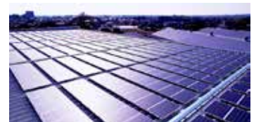
OKIクロステック（リベアセンター）：埼玉県鴻巣市 超軽量フレキシブルタイプの太陽光発電
